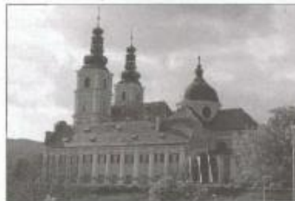
Die Wallfahrtskirche Maria Trost wurde besichtigt.
